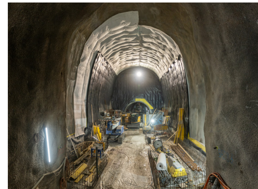
Vorbereitung für die folgenden Innenausbauarbeiten: Einbau der Abdichtung in der Längskaverne im Tiefenwinkel.
