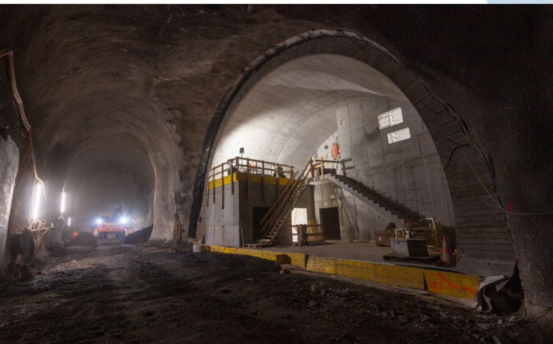
Die Querkaverne im Tiefenwinkel mit Innenausbau (rechts) neben der noch nicht ausgebauten Längskaverne (links).
