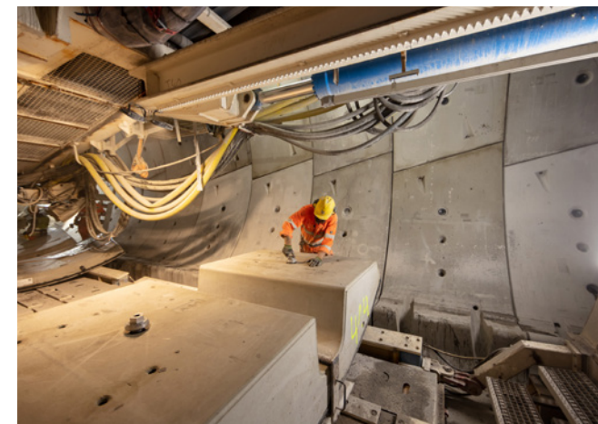
Ein Tunnelbauer bereitet den Einbau eines Sohlübbings vor.
