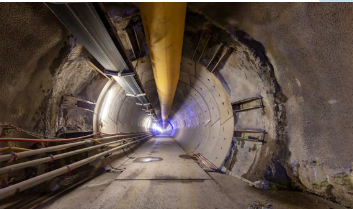
Übergangsbereich vom Sprengvortrieb zum TBM-Vortrieb mit Tübbingausbau
