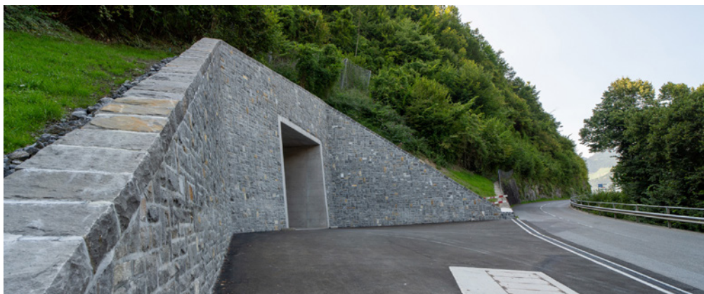
Das mit Natursteinen verkleidete Portal Tiefenwinkel an der Kerenzerbergstrasse (August 2025)
