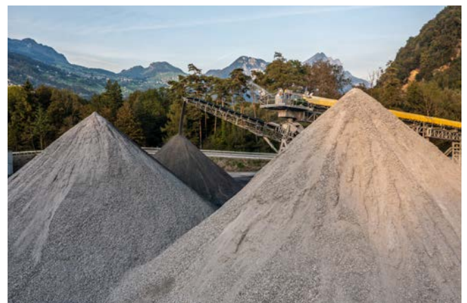
Abwurf des Ausbruchmaterials durch die Förderbandanlage – jeder Hügel entspricht 10m Tunnelstrecke
