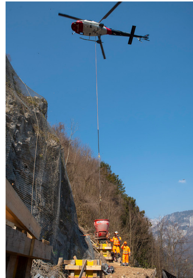
Installation der Hangmurennetze in Tiefenwinkel
