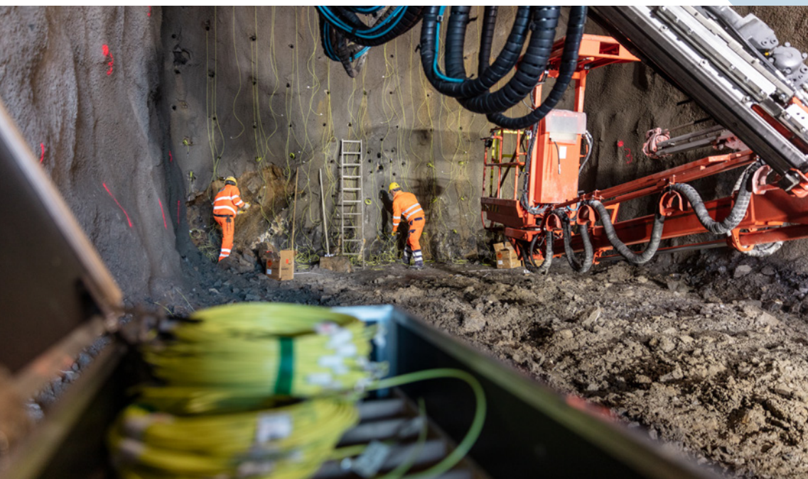
Vorbereitungsarbeiten für eine Sprengung auf Seite Gäsi
