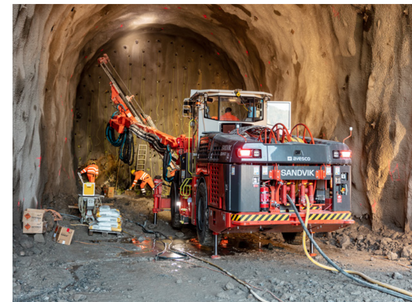
Ein «Bohrjumbo» bei den Vorbereitungen einer Sprengung
